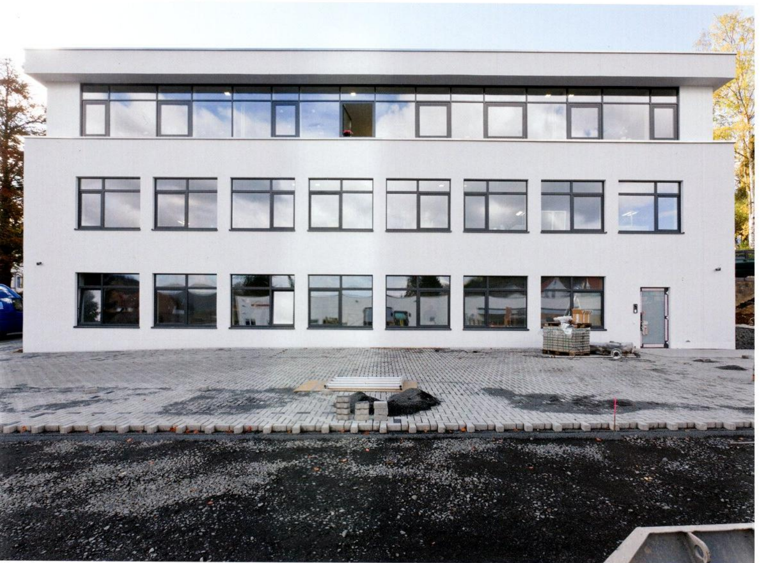
Die Rückseite des Gebäudes fällt vor allem durch die Versprünge auf. Dadurch scheint es, als schiebe sich der helle Bürotrakt aus der dunkleren Erschließungszone heraus. Im Gegensatz zu den gemauerten Wänden der unteren Geschosse besteht das Obergeschoss aus einer Pfosten-Riegel-Konstruktion aus Brettschichtholz.
